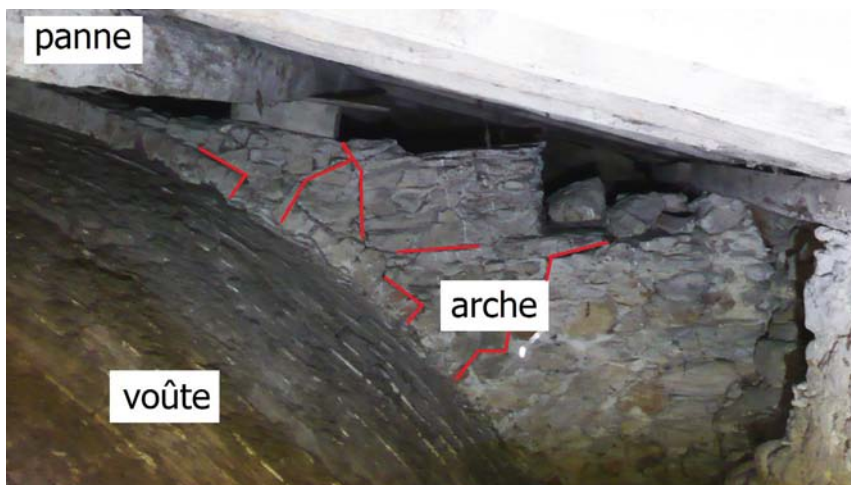
Les pannes reposant directement sur les arches.
